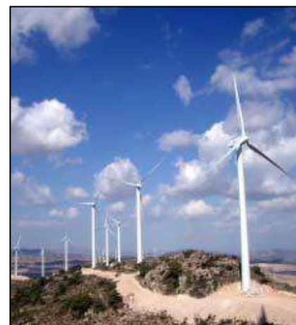
Imagen 4: Parque eólico. Fuente: Materiales Virtuales ESPA LOE
